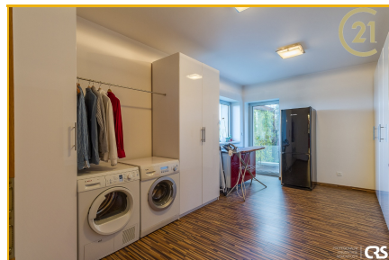
Technická místnost v 1. NP
